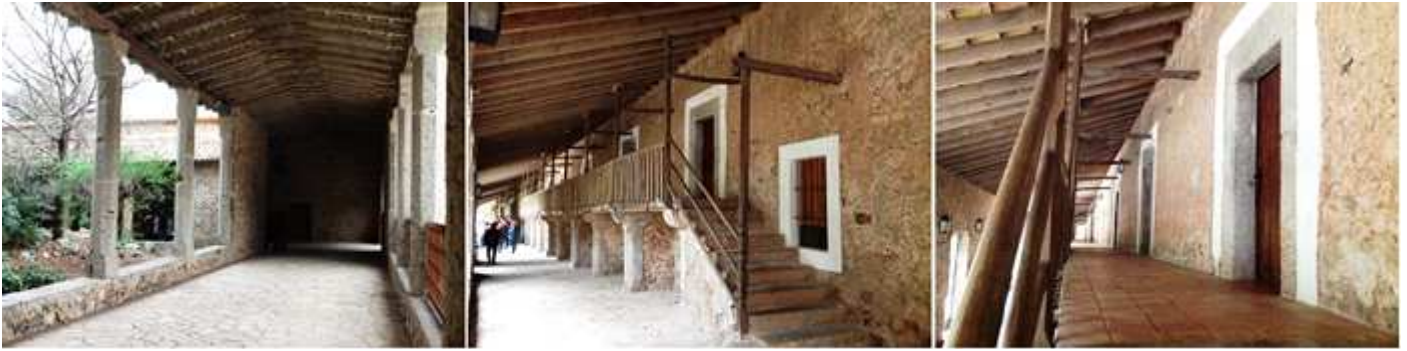
❶ Inicio de los porches, abiertos y con cubiertas de madera. ❷ En la parte superior eran los alojamientos y en la inferior se ataban las caballerías. ❸ Entrada a las estancias de los peregrinos.
