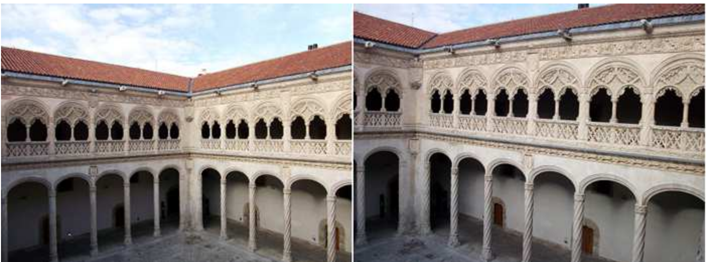
❶ Las columnas helicoidales, que están decoradas con bolas y con la cruz dominica y la flor de lis en los capiteles. ❷ Por la galería superior con arcos de medio punto geminados. Y sobre estas un friso con el yugo y las flechas que se repite en todo el contorno.
