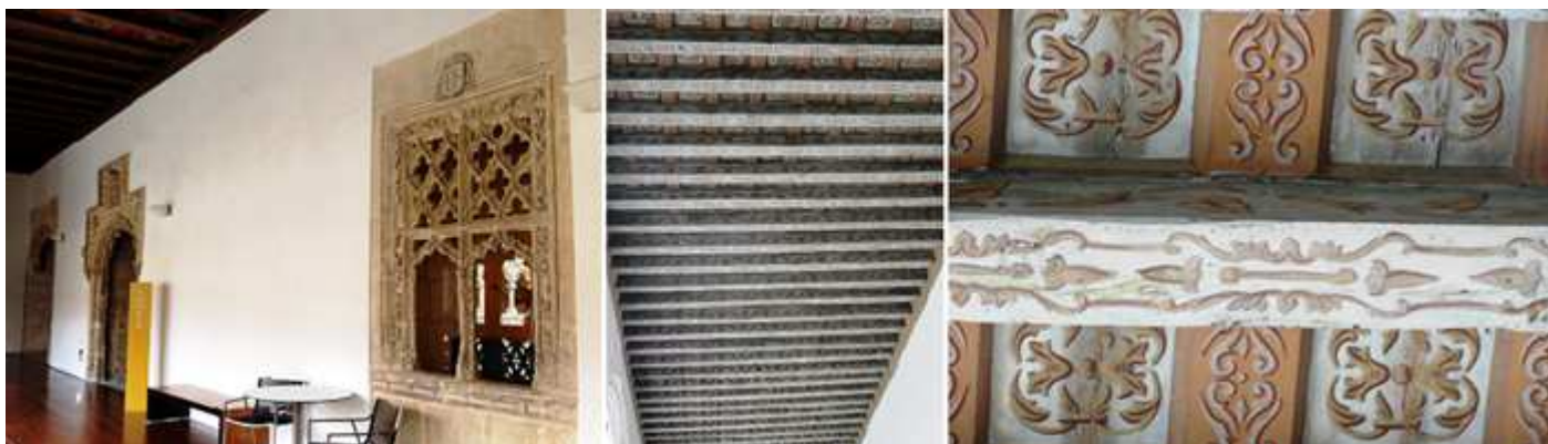
❶ Y salimos al punto inicial de las salas de este lado de la galería. ❷ Artesonado de la galería. ❸ Detalle con la decoración de su artesonado.
