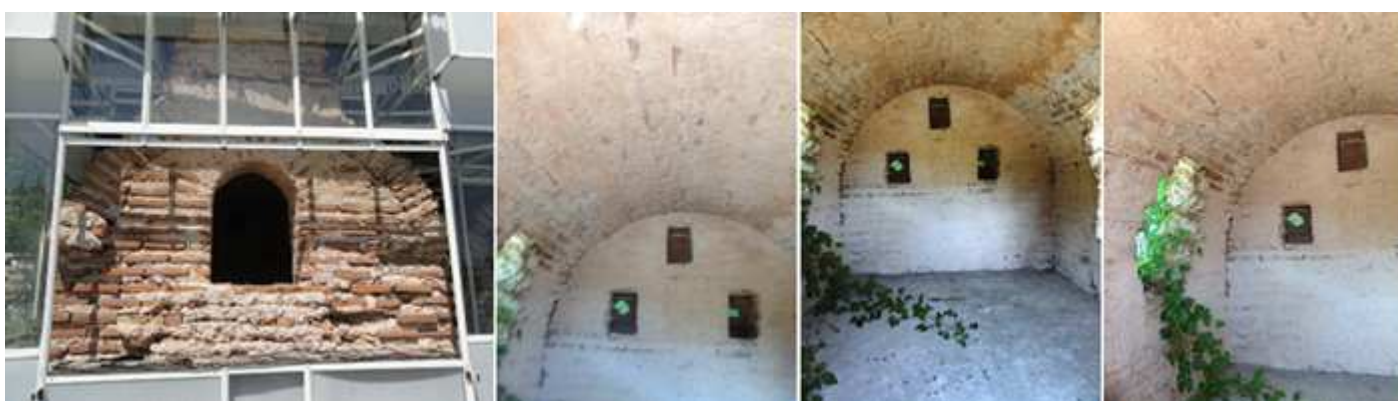
❶ La tumba con una estructura que la protege. ❷ Su bóveda de medio cañón. ❸ Está construida totalmente con ladrillos. ❹ Y posee además de la ventana de medio punto frontal tres en la cabecera y una en cada lateral.
