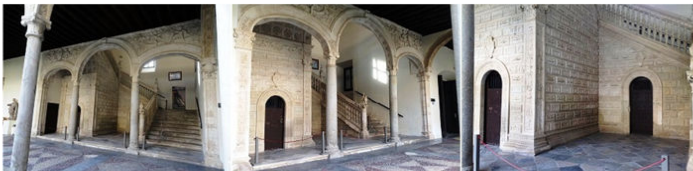
❶ Con tres arcos se abre la escalera en uno de sus laterales. ❷ Otra vista de su embocadura con el claustro. ❸ Los parámetros de la escalera se hallan almohadillados.
