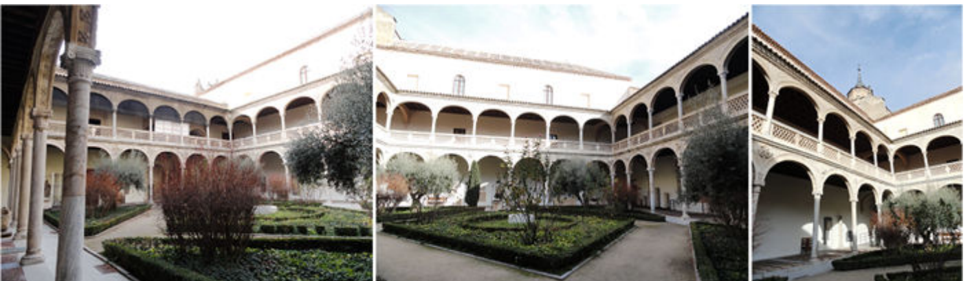
1 Claustro principal con dos plantas. 2 Sus galerías abiertas con arcos rebajados. 3 En sus alas están distribuidas las piezas.
