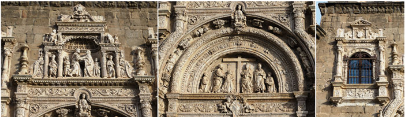
❶ Segundo cuerpo de la portada con cuatro columnas, en la parte central el abrazo de San Joaquín y Santa Ana, a sus lados las figuras de los patriarcas. ❷ Adoración de la Cruz por Santa Elena, San Pedro y San Pablo y arrodillado el cardenal Mendoza (a los pies de Santa Elena). ❸ A los lados se abren dos ventanas, con marco plateresco.
