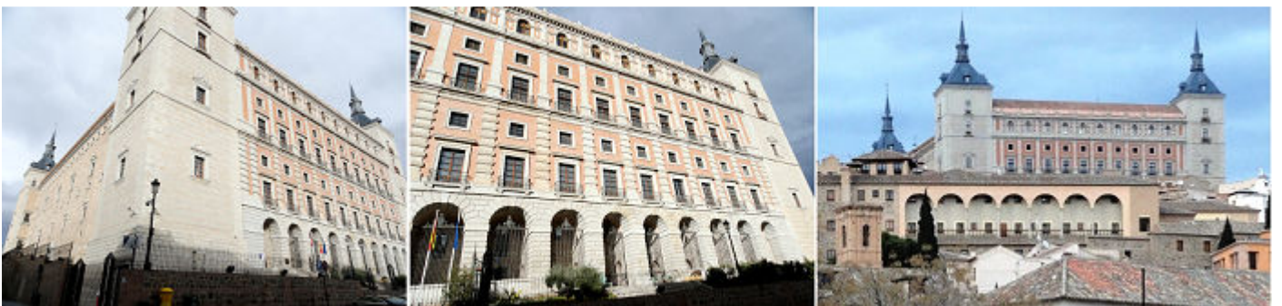
❶ Esquina Cuesta de los Capuchinos con la calle de la Unión. ❷ Fachada porticada al sur diseñada por Juan de Herrera. ❸ Panorámica del Alcázar desde la otra orilla del río Tajo.
