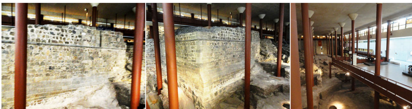
❶ Bastión Trastámara, a modo de torre albarrana de planta rectangular. ❷ Se encontraba exento y avanzado del cuerpo principal del Alcázar medieval. Tras la capa de cal visible, esta construcción sepulto otros niveles más antiguos. ❸ Subimos otro nivel para tener una mejor perspectiva.
