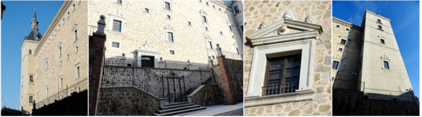
❶ Fachada a la Cuesta de Carlos V. ❷ En esta calle hay una entrada de uso militar. ❸ Sus ventanas con un frontis triangular que alberga una cara. ❹ En cada ángulo hay una torre de planta cuadrada.
