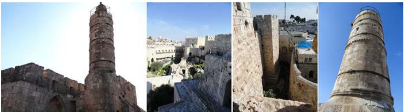
❶ Perspectiva de la torre. ❷ Vista del interior de la ciudadela desde esta situación. ❸ Parte de los muros y fosos de esta parte sur. ❹ La torre de planta redonda posee cuatro o cinco anillos metálicos de refuerzos.
