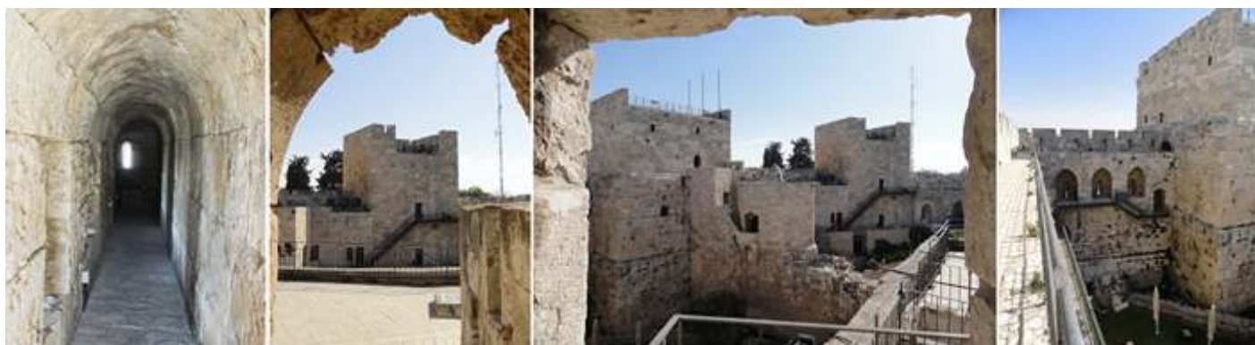
❶ Pasillo que recorre los matacanes y comunica distintos frentes de las murallas ❷ Salida a las terrazas frente a las torres principales. ❸ La torre de Herodes a la izquierda. ❹ Concluimos esta visita superior junto al torreón que hemos iniciado la visita.
