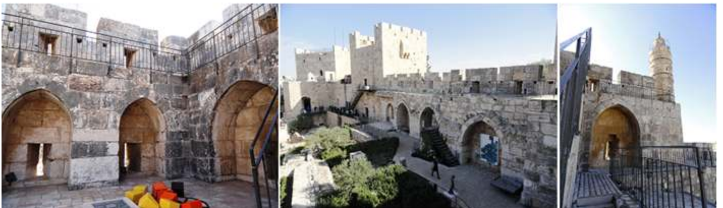
❶ Distintos albergues defensivos a varios niveles. ❷ Otra toma de este mismo lateral del Este de la ciudadela que en el exterior está la calle The Armenian Patriarchate St. y el sector armenio además de la oficina de correos casi pegada a esos muros. ❸ Al fondo la torre musulmana de finales del S. VII.
