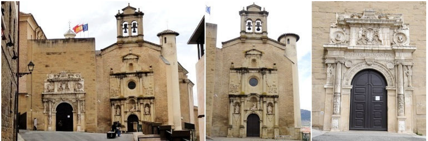
1 Fachada del conjunto del museo. 2 La fachada de la iglesia es de tres cuerpos en piedra sobre el resto de ladrillo y con un espadaña de dos vanos que la corona. 3 A su izquierda dispone de una torre redonda. Esta portada procede de una iglesia de Puente la Reina y se instaló en 1934. 4 Portada del Hospital obra de Juan de Villareal en la que figura su fecha de ejecución 1556.
