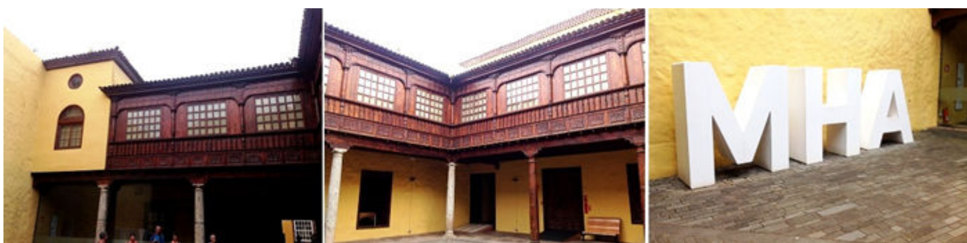
❶ Galería de planta baja con columnas de piedra alguna parte de ella está acristalada. ❷ Y la segunda planta completamente cerrada de madera con sus respectivos ventanales apaisados. ❸ Logotipo del museo en este patio.
