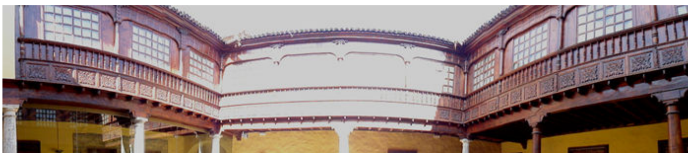
❶ Panorámica del patio con la galería de la primera planta cerrada y acristalada..
