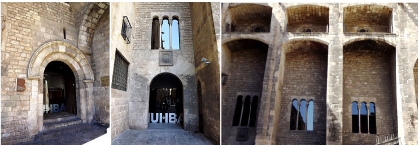
❶ Puerta de acceso que da a la escalinata ❷ Otra puerta bajo el salón. ❸ Ventanales del salón entre los contrafuertes.
