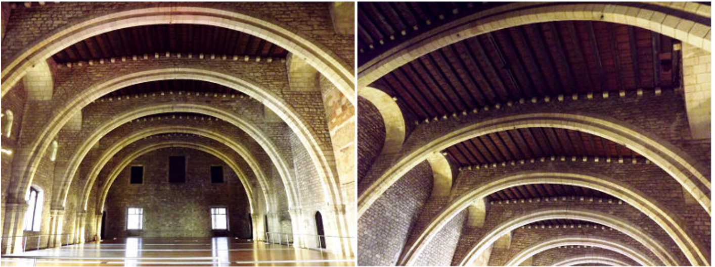
❶ Seis enormes arcos de diafragma sustentan la techumbre. ❷ Y en los laterales con arcos de medio punto.
