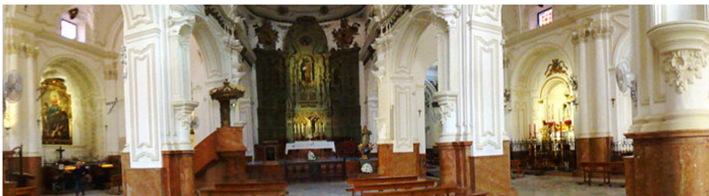
❶ Parte central de la Iglesia de Santiago Apóstol una de las cuatro primeras construidas tras la Reconquista.
