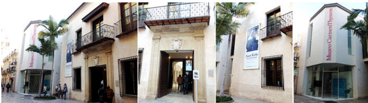
❶ Fachada de las instalaciones del museo a la calle Compañía. ❷ Portada renacentista del Palacio Villalón. ❸ Lateral del palacio. ❹ Edificio anexo colindante.
