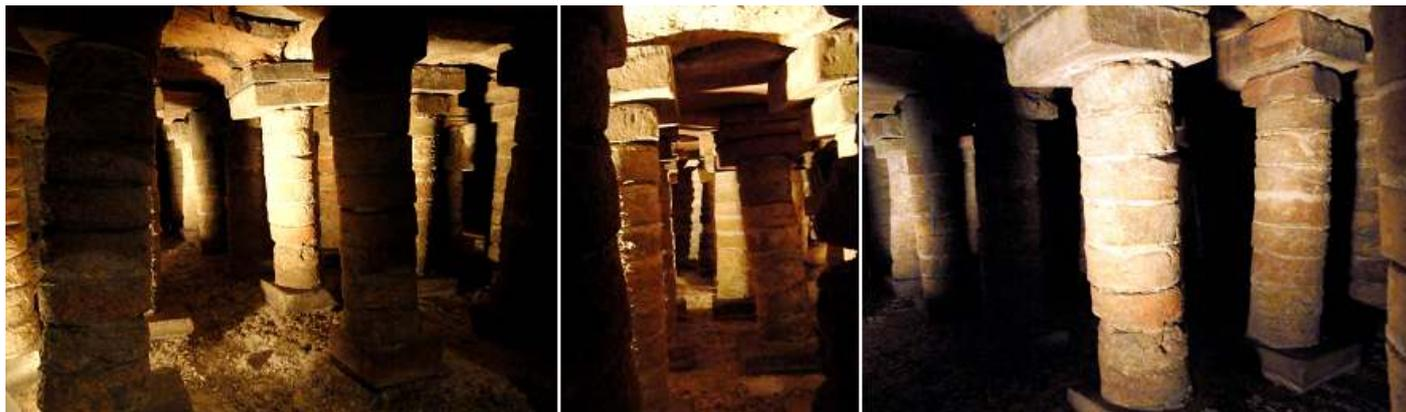
❶ Los hipocaustos (sistema de calefacción). ❷ Que a través de ellos se conduce el aire caliente a las estancias. ❸ Las conducciones construidas con ladrillos redondo para formar las columnas que sostienen los diferentes conductos.
